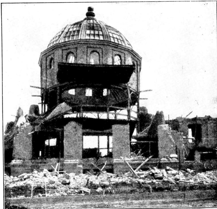
14: Fig. 14. — Universitetsbiblioteket vid Stanford University i Kalifornien efter jordbäfningen 1906. Bilden visar järnkonstruktioners stora hållfasthet, jämförd med murverks. Jordbäfningens inverkan på låga trähus synes på fig. II.
